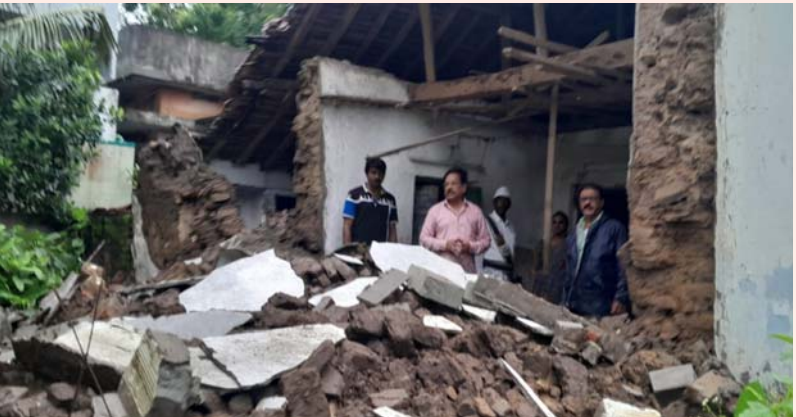
అధికారులను తహసీల్దార్ ఆదేశించారు.
