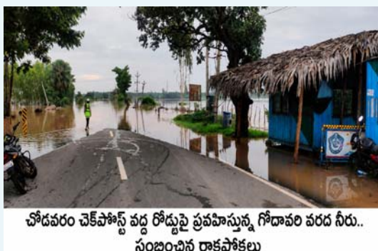
చోడవరం చెక్ పోస్ట్ వద్ద రోడ్డుపై ప్రవహిస్తున్న గోదావరి వరద నీరు.. స్తంభించిన రాకపోకలు
