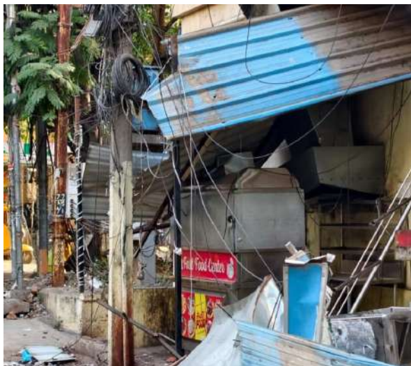
రాజేంద్రనగర్, ఏప్రిల్ 11 (ప్రజా జ్యోతి) ఫుట్ పాత్ లు ఆక్రమించి అక్రమ నిర్మాణాలు
