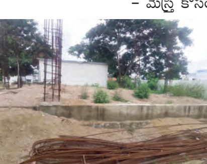
కమ్మరపల్లి సెప్టెంబర్ 12,ప్రజా జ్యోతి. కమ్మర పల్లి మండలం కొనసాగడం గ్రామం లోని జిల్లా పరిషత్ పాఠశాలలో నిర్మాణం లో వున్న అదనపు గదులు బేసమేట్ వరకు వచ్చి ఆగి పోయినట్లు తెలుస్తోంది.పిఎం శ్రీ క్రింద మంజూరు ఐన అదనపు గదుల నిర్మాణం కోసం ప్రభుత్వం 32
