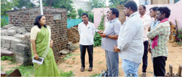
వీరూర్ జూలై 08 (ప్రజాజ్యోతి) గ్రామ పంచాయతీ చింకాగ్రా గ్రామములో సబ్ కలెక్టర్ ఇందిరమ్మ ఇండ్ల నిర్మాణం పనులను పరిశీలించారు. నూతనంగా ఇందిరమ్మ ఇండ్ల కట్టుకొని వారికి కట్టుకొని తెలిపారు. పనులు జరిగే కొద్దీ బిల్లును మీ ఆకౌంట్లో జమ అవుతాయని తెలిపారు ఈ కార్యక్రమం లో ఎంపీడీఓ మహబూబ్, పంచాయతీ కార్యదర్శి గ్రామ ప్రజలు లభిదారులు పాల్గొన్నారు.
