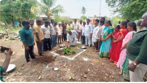
కలిపి ఇందిరమ్మ ఇండ్ల నిర్మాణ పనులకు శంకుస్థాపన చేశారు. ఈ కార్యక్రమంలో ఏ ఎం సి డైరెక్టర్ తిప్ప ని
