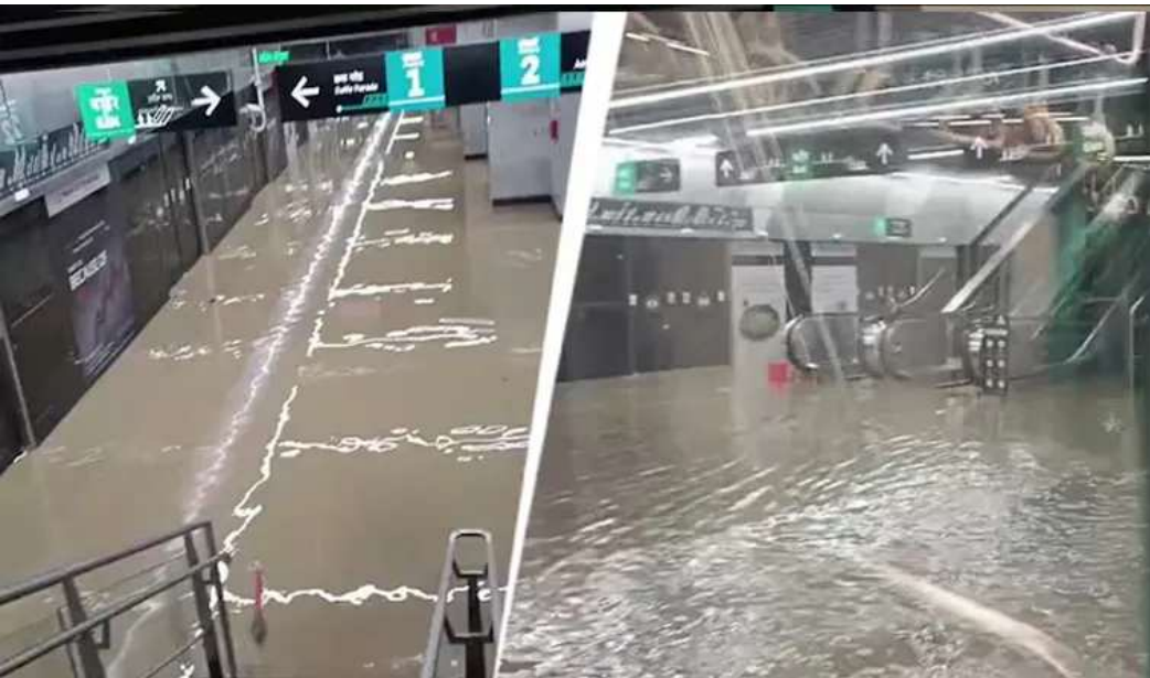
ముంబై మూడు రైన్ల అండర్గ్రౌండ్ మెట్రోస్టేషన్ న్న బాంద్రా-కుర్లా కాంప్లెక్స్ నుండి వర్షిలోని ఆచార్య ఆశ్ర్మ చౌక్ వరకు సేవల్ని అందిస్తోంది. ఈ మెట్రో సేవలు ఈ నెల ప్రారంభంలో మే 10న అందుబాటులోకి వచ్చాయి. ఇటీవలే ప్రారంభమైన మెట్రోస్టేషన్‌ను వరద నీరు ముంచెత్తడంతో మౌలిక సదుపాయాల గురించి ప్రశ్నలు తలెత్తాయి.
