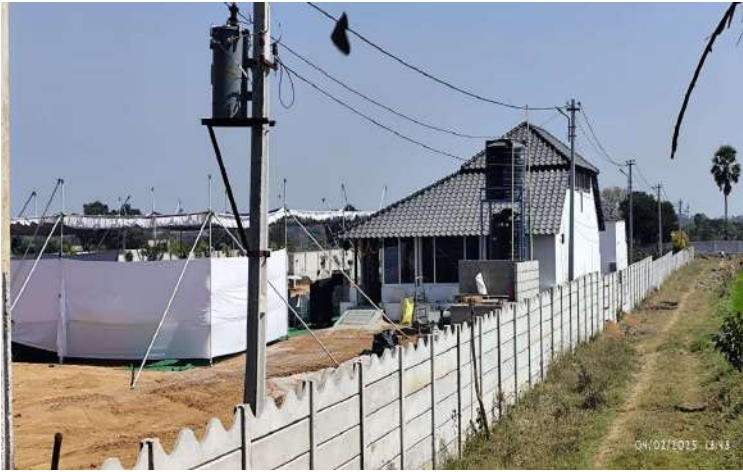
-నిబంధనలు పాటించకపోయినా పట్టించుకోని అధికారులు -అక్రమ నిర్మాణాల పై సొమ్ము చేసుకుంటున్న పంచాయతీ అధికారులు
