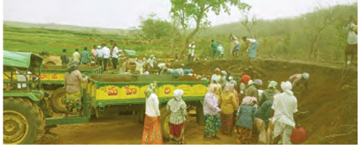
రాజంపేట మండలంలోని కొండాపూర్ గ్రామపంచాయతీలో ఉపాధి హామీ పనిలో భాగంగా జరుగుతున్న ఫార్మేషన్ రోడ్డు పనిని మంగళవారం డి ఆర్ డి ఓ చందర్ నాయక్ ఆకస్మితంగా తనిఖీ చేశారు. అక్కడ ఉన్న ఉపాధి హామీ కూలితో మాట్లాడి అక్కడ జరుగుతున్న పనుల గురించి వివరాలు అడిగి తెలుసుకున్నారు. రోజూ వారి కూలి 272/-రూపాయలు వచ్చే
